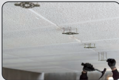
Enfoncer les entretoises jusqu'au contact de la poutelle, sans la soulever.
