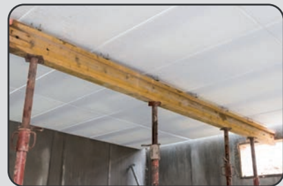
Placer la file d'étais au contact des entretoises, sans forcer.
