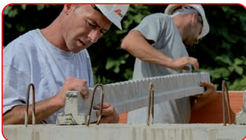
Poser les poutrelles.
