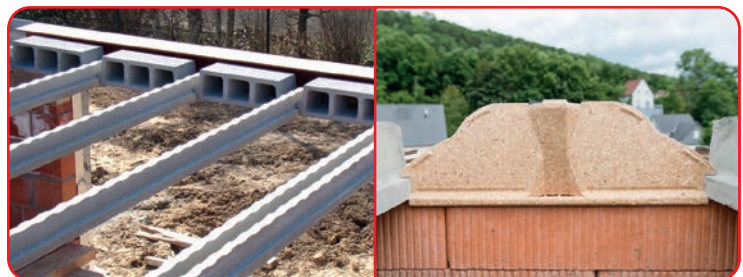
Fixer l'entraxe des poutrelles en posant un entrevous (ou un obturateur ou un rupteur thermique) en intercalaire.
